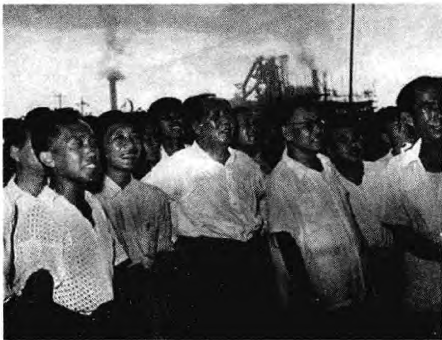
1958年9月13日，毛泽东视察武汉钢铁厂。（摄影/侯波）
