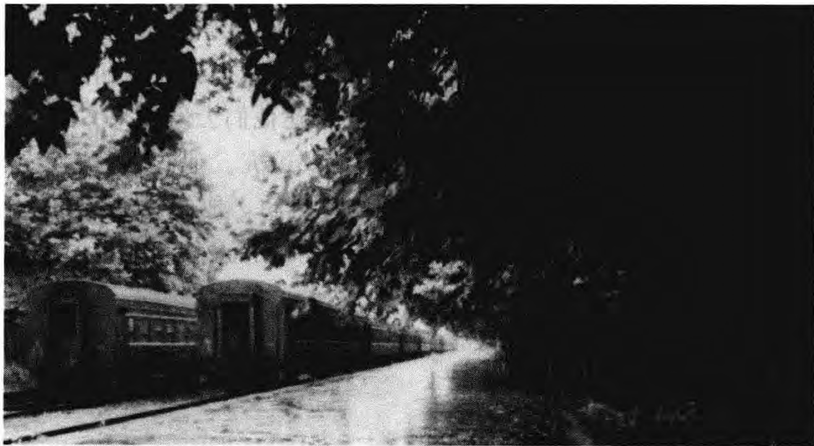
长沙大托铺专列停车支线。
